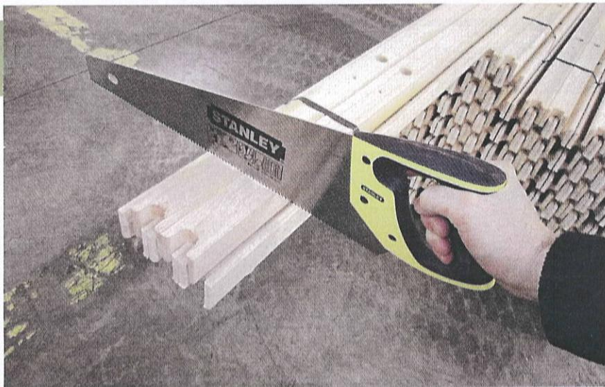
Les rails sont conditionnés par bottes de 5. C'est le nombre nécessaire de montants verticaux pour une longueur d'environ 2 m, laissant un entraxe de 60 cm. Une disposition répondant aux habitudes de travail des plaquistes. Une fois la hauteur sous plafond mesurée, il suffit d'un coup de scie pour donner la bonne dimension aux cinq éléments en même temps.
