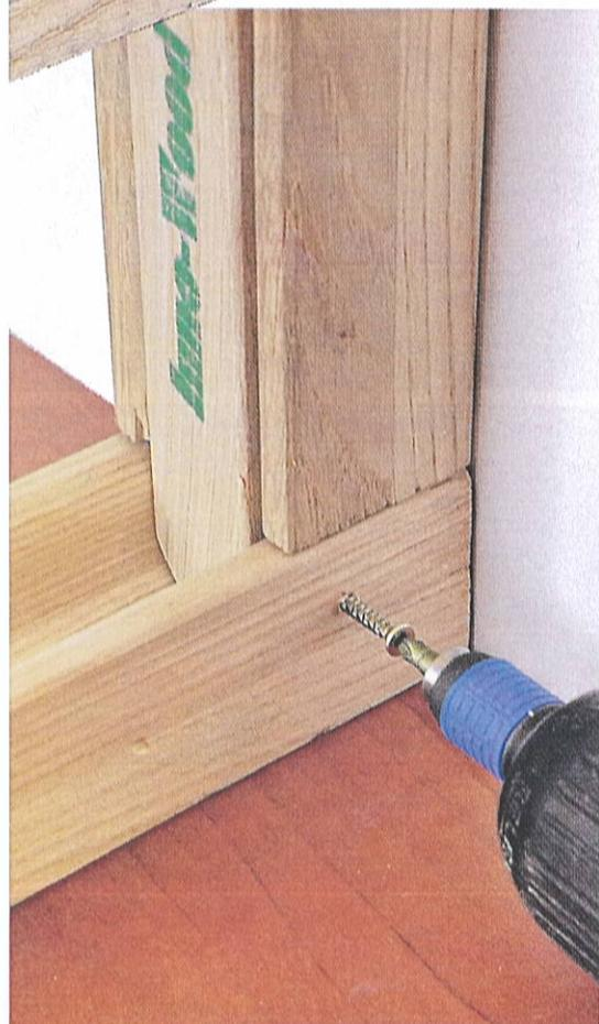
À l'endroit de la découpe, une clavette courte assure la solidité de l'assemblage à angle droit.
