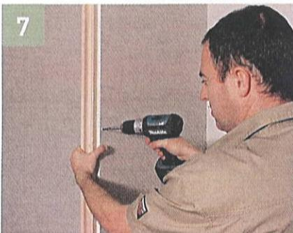
7 Une seule dimension de profilés, identiques, qu'ils soient horizontaux ou verticaux. Leur hauteur est définie pour offrir une bonne assise aux plaques de plâtre. Il ne reste qu'à les positionner et à les visser. On peut aussi y clouer des lames de lambris.
