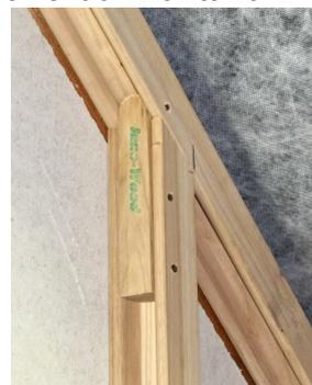
Dans le cas des **plafonds rampants**, la clavette sera placée en haut pour permettre une coupe du montant en biais.
