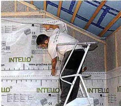
**13** Poursuivez la mise en place du frein-vapeur en faisant se chevaucher les lés, afin que cet écran régulateur de vapeur et d'étanchéité à l'air soit bien hermétique.
