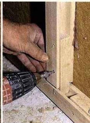
**6** Doublez ensuite cette isolation avec une ossature bois. Les montants sont reliés au rail bas par une clavette fixée par 3 vis auto-perçantes (une sur le rail, deux sur le montant).
