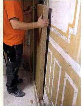
**3** Le mur nettoyé de ses moulures, insérez un premier panneau de fibres de bois entre le rail et la paroi.
