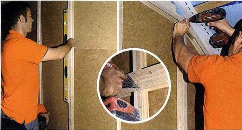
**7** Vérifiez régulièrement l'aplomb des montants (entraxe : 60 cm) au fur et à mesure de la pose. Si besoin, prolongez-les à l'aide de clavettes longues fixées avec 4 vis. Les montants sont vissés au rail haut (ou intermédiaire selon l'inclinaison du toit).
