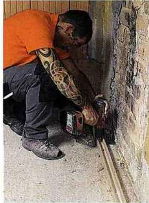
**1** Vissez le rail bas à 60 mm du mur (du liège en sous-face réduit les vibrations). Fixez rails haut et intermédiaire.
