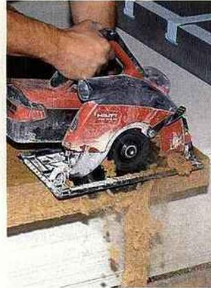
**2** Après mesure et traçage, découpez les panneaux de fibres de bois à dimension à l'aide d'une scie circulaire.
