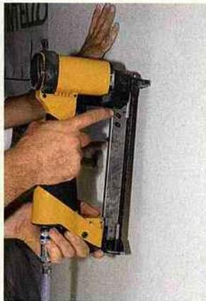
**15** Après repérage des montants, vissez une plaque de fibro-plâtre (13 vis au m² en vertical) en commençant par le bas. Contrôlez et ajustez l'aplomb en intercalant de petites cales sous la plaque.
